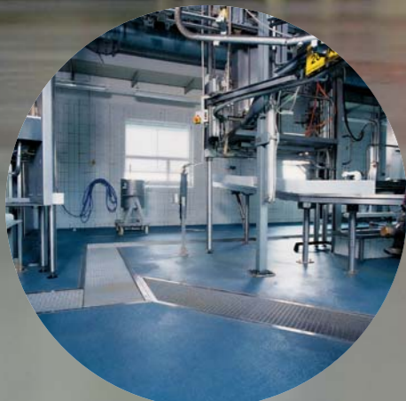
flüssigkeitsdichte Einarbeitung von Rinnen – WHG gerecht
