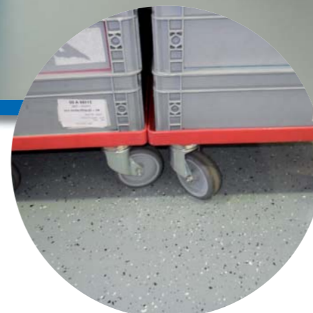
für permanente Nassbelastung ausgelegte, rutschfeste Einstreu- beläge
